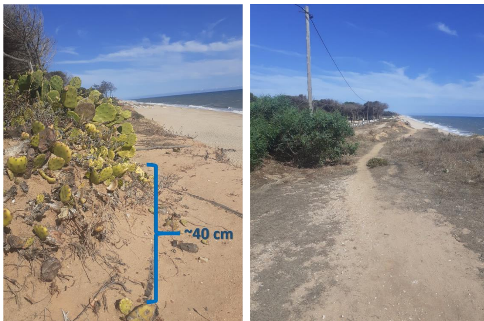
Figura 5.41 - Imagem do topo da arriba. À esquerda: maciço de Opuntia sp. A presença deste cato evitou que uma pequena área fosse pisoteada evitando um rebaixamento do solo, por erosão, de mais de 40 cm. À direita, caminho aberto pelos elevadíssimos níveis de pisoteio, podendo verificar-se o desaparecimento da vegetação
